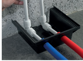
Fig. 40 Cut conduit box for wall termination
