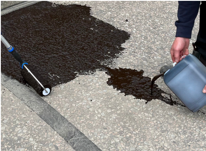
Pouring Road Shield
