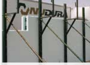
Align wall for concrete pour
