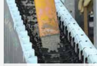
Pour concrete into walls
