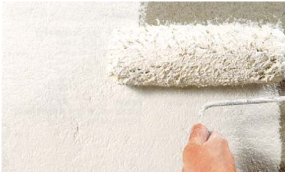
Applying the primer
