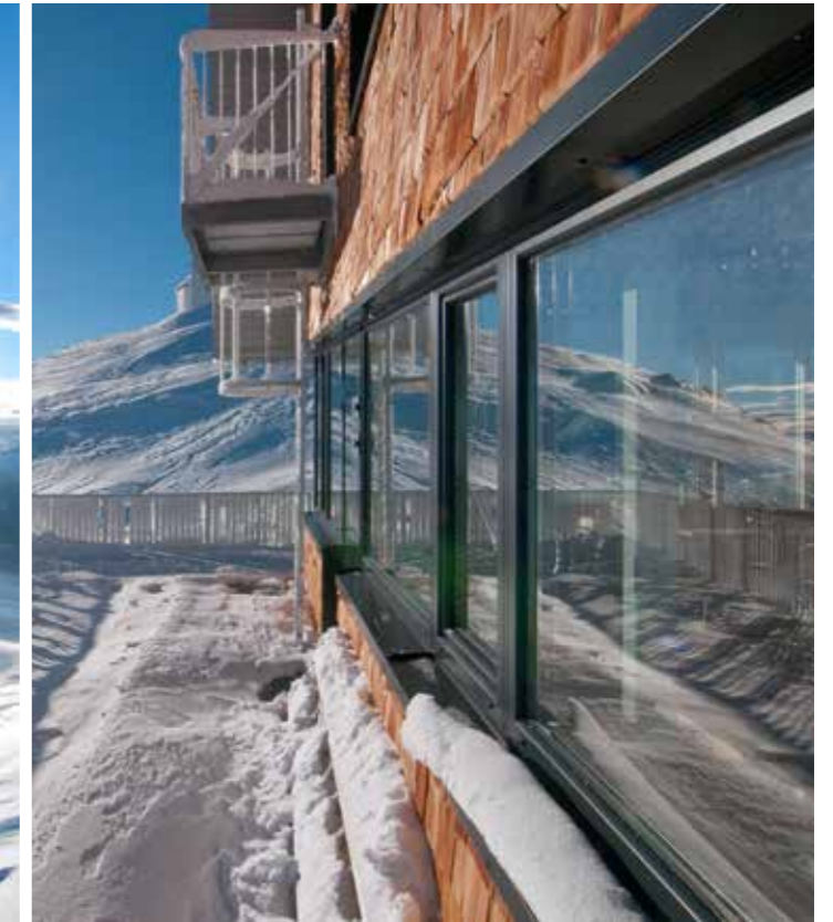
Dobratch summit house 2143 m, Transform Architekten ZT-GmbH, Architekt DI Günter Weratschnig
