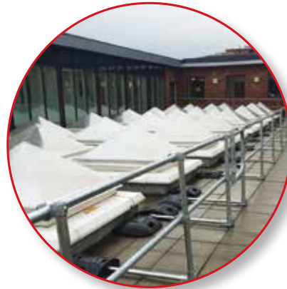
Roof Edge Protection
